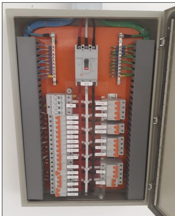
Figura 24. Identificação de circuitos.
