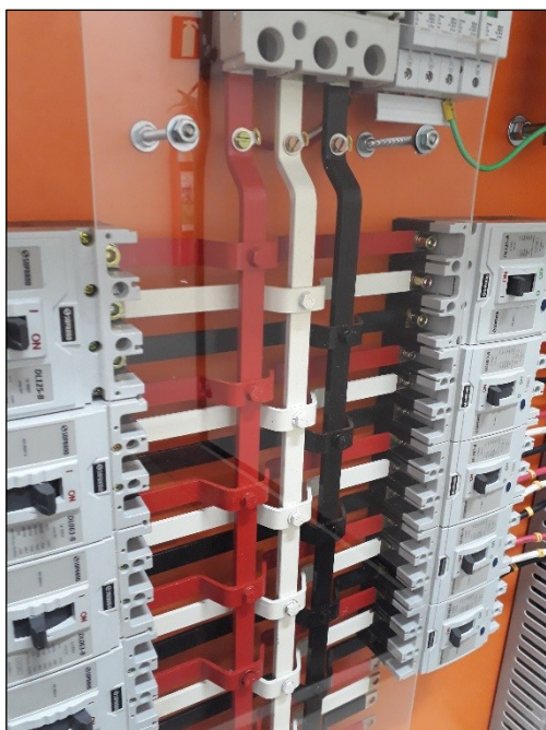
Figura 18. Padrão de barramento dos QDs.
