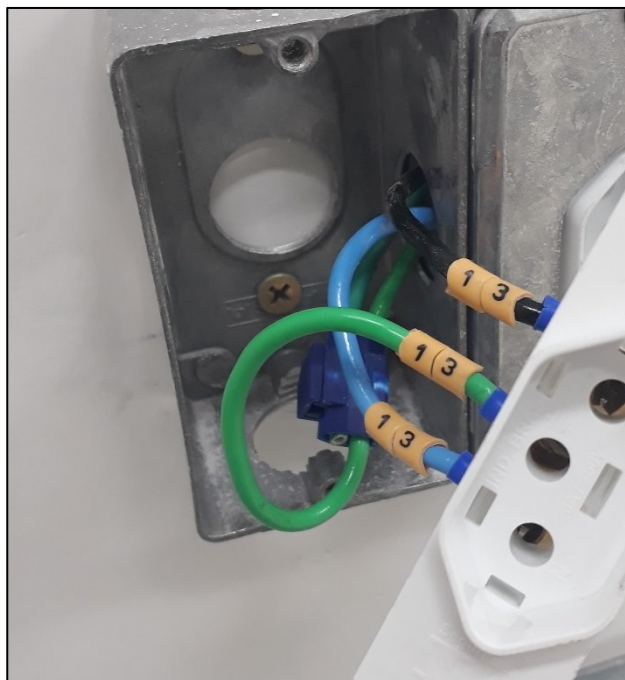
Figura 4. Anilha no ponto terminal.
