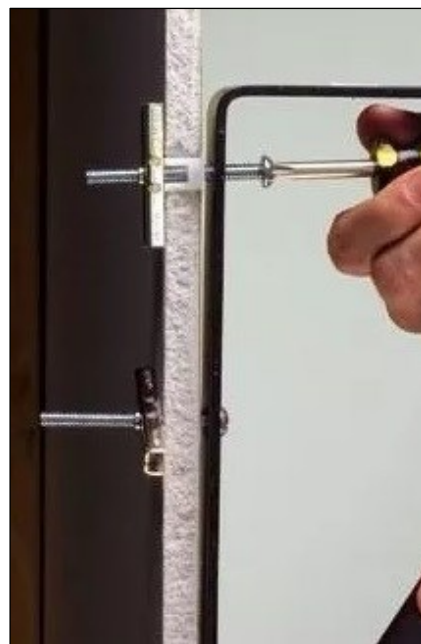
Figura 13. Haste para dry wall.
