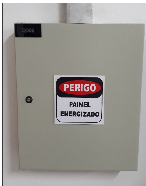
Figura 27. Identificação externa dos quadros.
