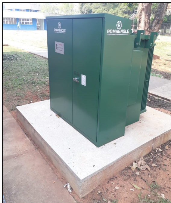
Figura 30. Transformador de pedestal.
