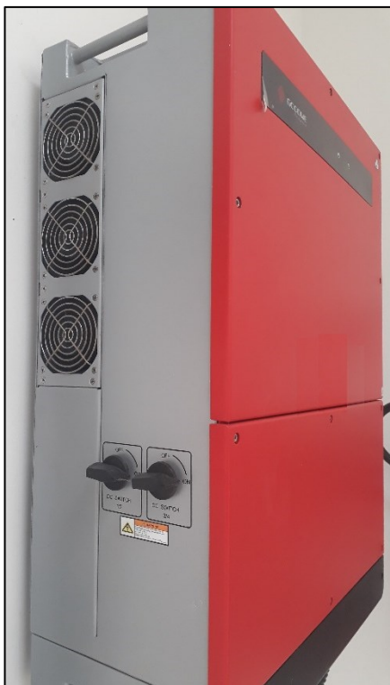
Figura 36. Desligar DC SWITCH depois de desligar o disjuntor.
