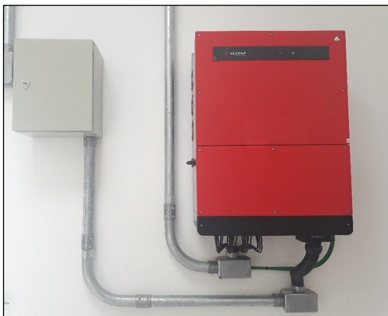
Figura 34. Quadro com disjuntor à esquerda, e inversor à direita.
