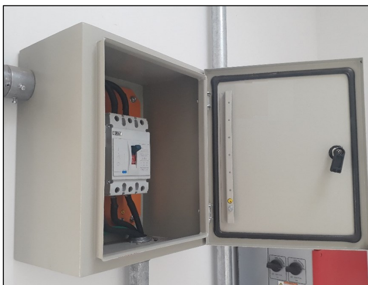
Figura 35. Disjuntor deve ser desligado primeiro.
