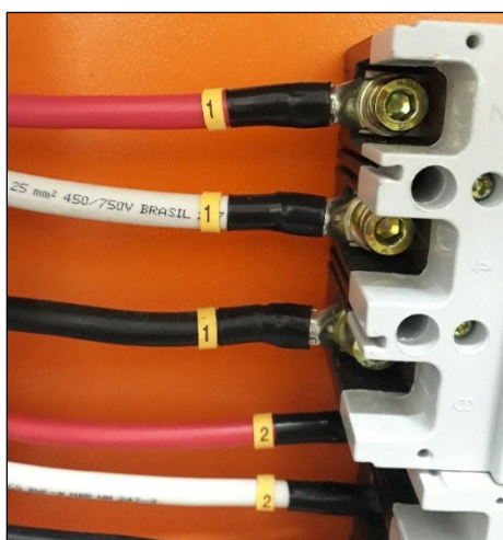
Figura 20. Anilhas e termocontratil.
