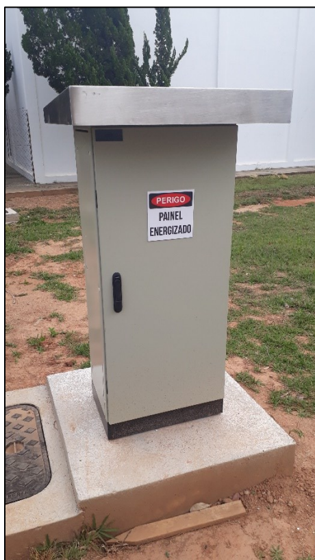
Figura 16. Cobertura em chapa de aço inoxidável.
